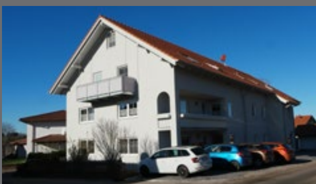
Schwabbruck: Umbau und Anbau, 8 Wohnungen Bauherr: Privat Fertigstellung: 2020
