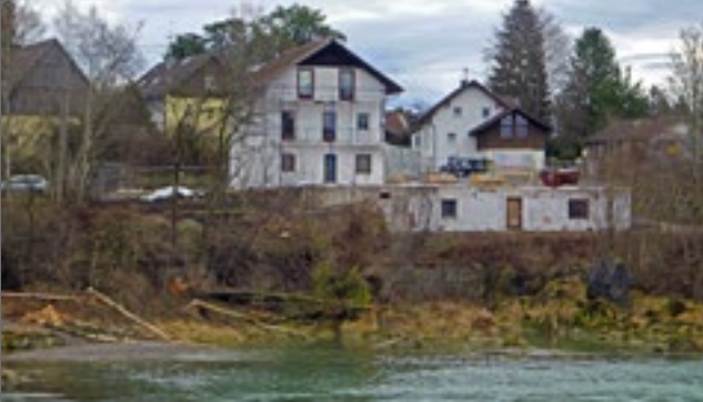
Prem am Lech, Ortsteil Gründl: Umbau ehemalige Pizzeria zu 12 WE Bauherr: Bauträger Fertigstellung: 2022
