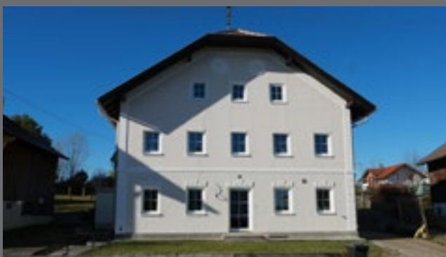
Altenstadt-Schwabniederhofen Sanierung des Gebäudes im Bestand Bauherr: Privat Fertigstellung: 2021
